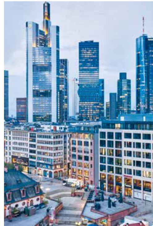
Energieeffiziente Aufzüge und digitale Mobilitätslösungen: BIG | Bjarke Ingels Group, Omniturm, Frankfurt am Main 2016–2020, Foto: Manuel Rickenbacher/Schindler
