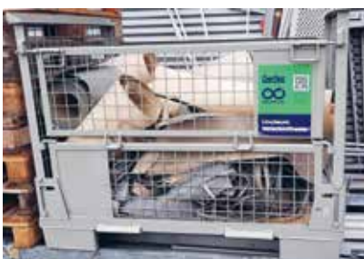
Auf einer Baustelle werden Linoleum-Verschnittreste gesammelt, um der Wertstoffkette wieder zugeführt zu werden, Foto: Gerflor
