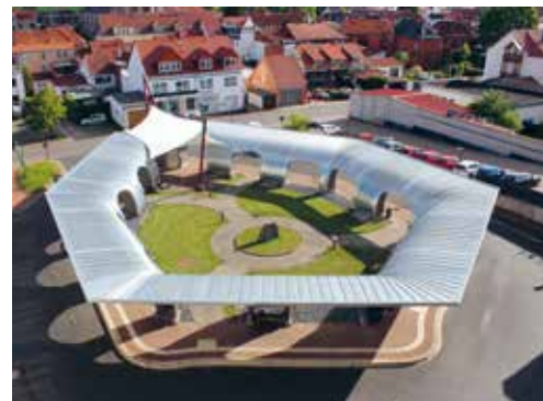
Christian Brüstel Freier Architekt, Bus- bahnhof Dingelstädt, 2020, Foto: Rheinzink
