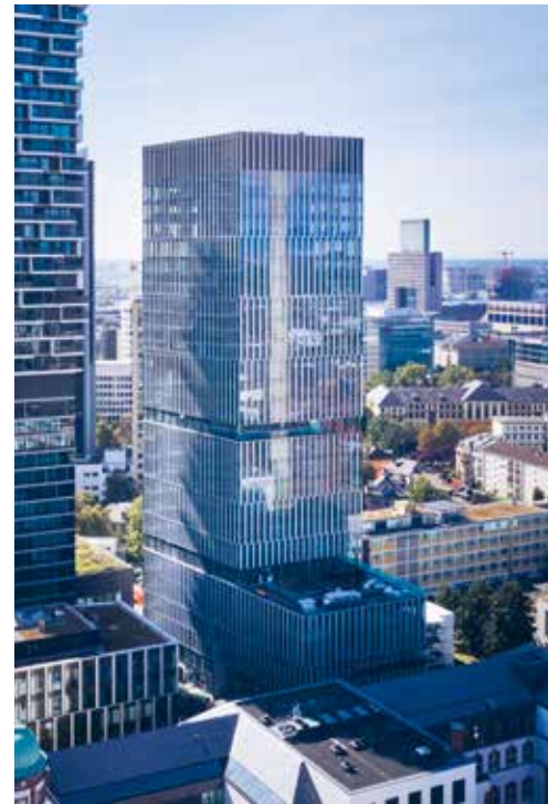
Mit einer Fassade aus Recycling-Aluminium realisiert: cyrus moser architekten BDA, Senckenberg-Turm, Frankfurt/Main 2021, Foto: Mediashots/WICONA
